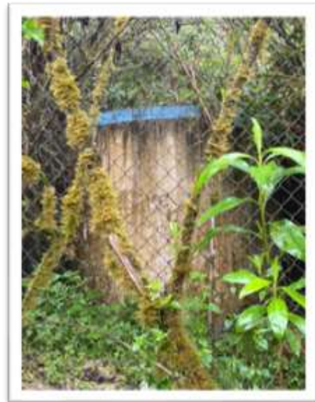
Imagen 23. Vista lateral de la estructura
