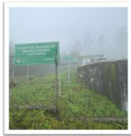
Imagen 21. Planta de tratamiento.
