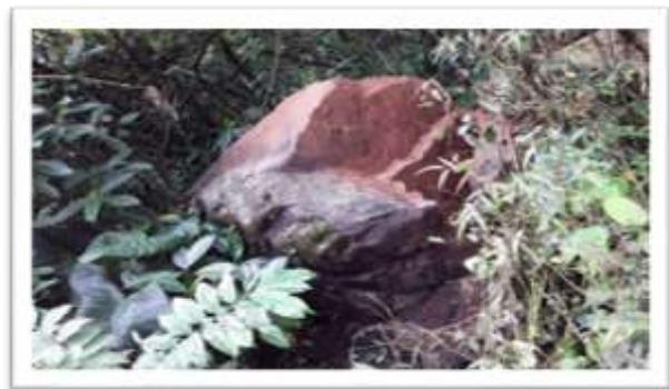
Imagen 19. Obstrucción en captación.
